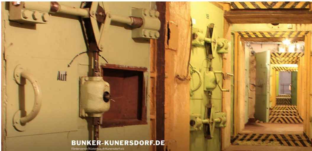
Das Objekt 17/448, Tarnname "Wetterbeobachtungsstation"- Die schwer verbunkerte Sendestelle der Hauptführungsstelle des MfNV bei Kunersdorf
